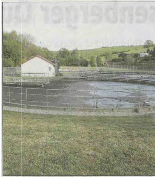
Die Kläranlage des ZWE zwischen Eisenberg und Kursdorf. Foto: Archiv/Claudia Bioly
