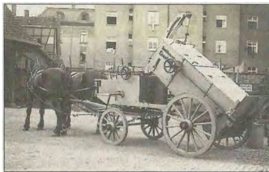
Aus der Historie der Eisenberger Wasserversorgung: Fäkalienabfuhr 1929 Foto: Stadtarchiv Eisenberg
