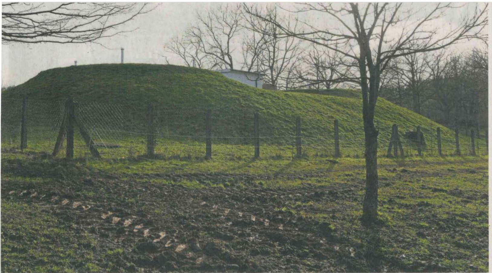
Der Hartmannsdorfer Hochbehälter des Zweckverbandes im Februar 2021.
