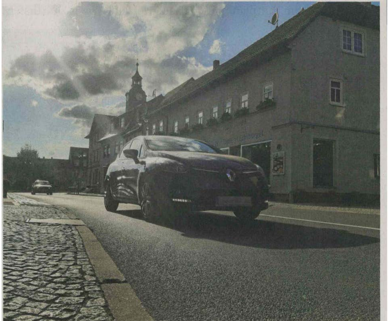
In Bürgel wird ab Mitte September die Bundesstraße erneuert.
