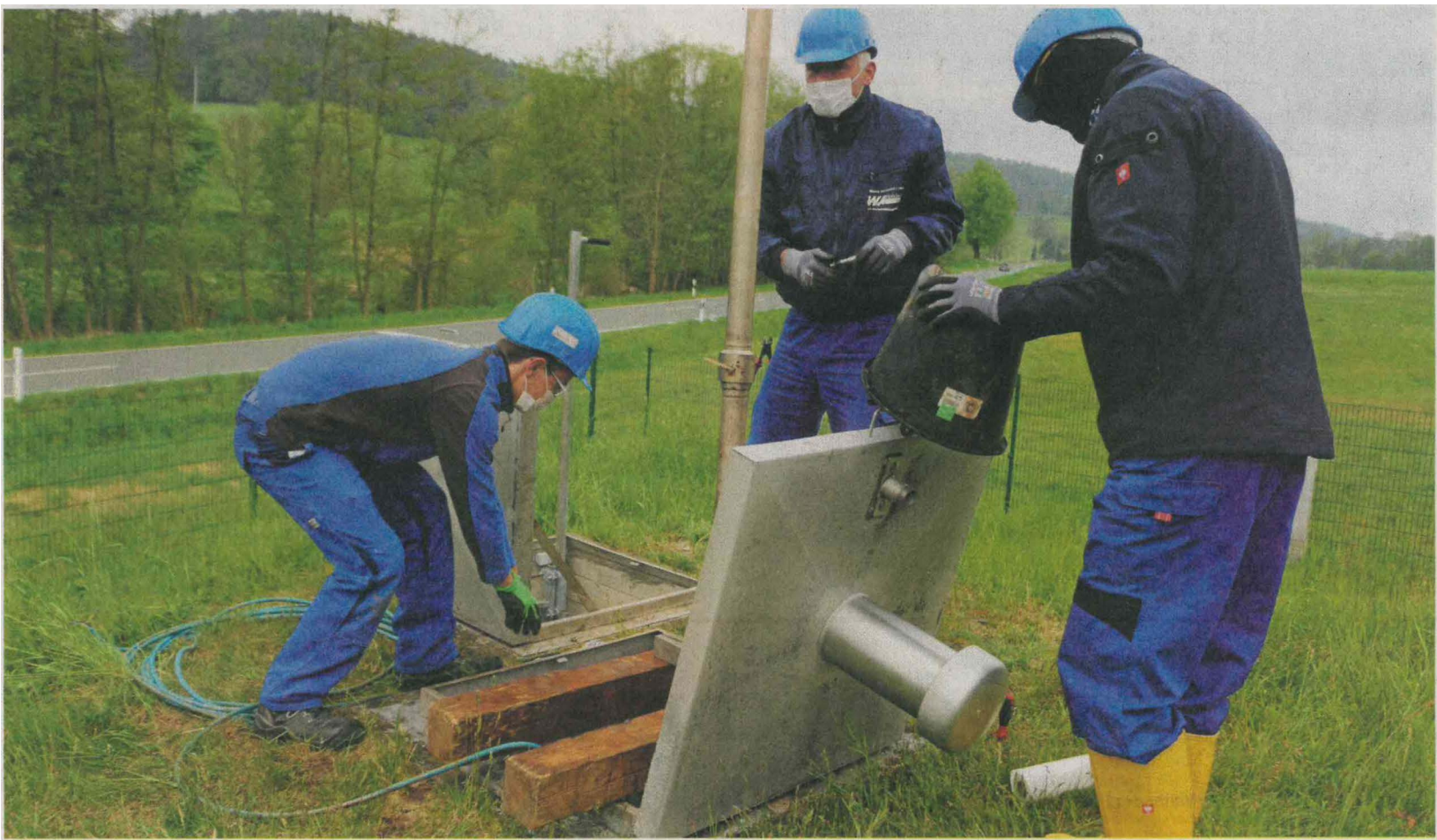
Mitarbeiter des ZWA „Thüringer Holzland“ bei der Umrüstung eines Tiefbrunnens in der Gemeinde Ottendorf.
