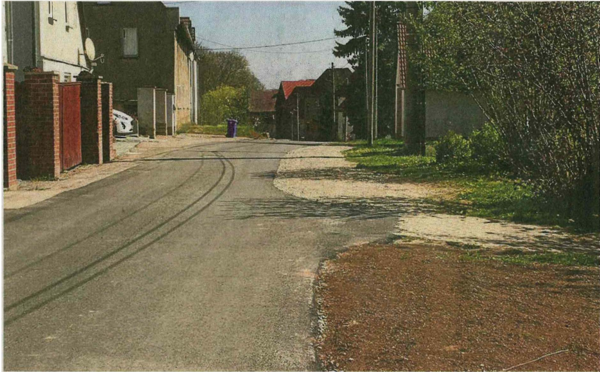
Blick in den Rosentalsweg in Etzdorf: Der ZWE hat hier in den vergangenen Monaten einen Abwasserkanal verlegt. Anschließend ist die Straßendecke an einigen Stellen schmaler aufgebracht worden als zuvor. Das ärgert einige Anwohner, da nun an den Engstellen keine zwei Autos mehr aneinander vorbei kommen würden. FOTO: SUSANN GRUNERT
