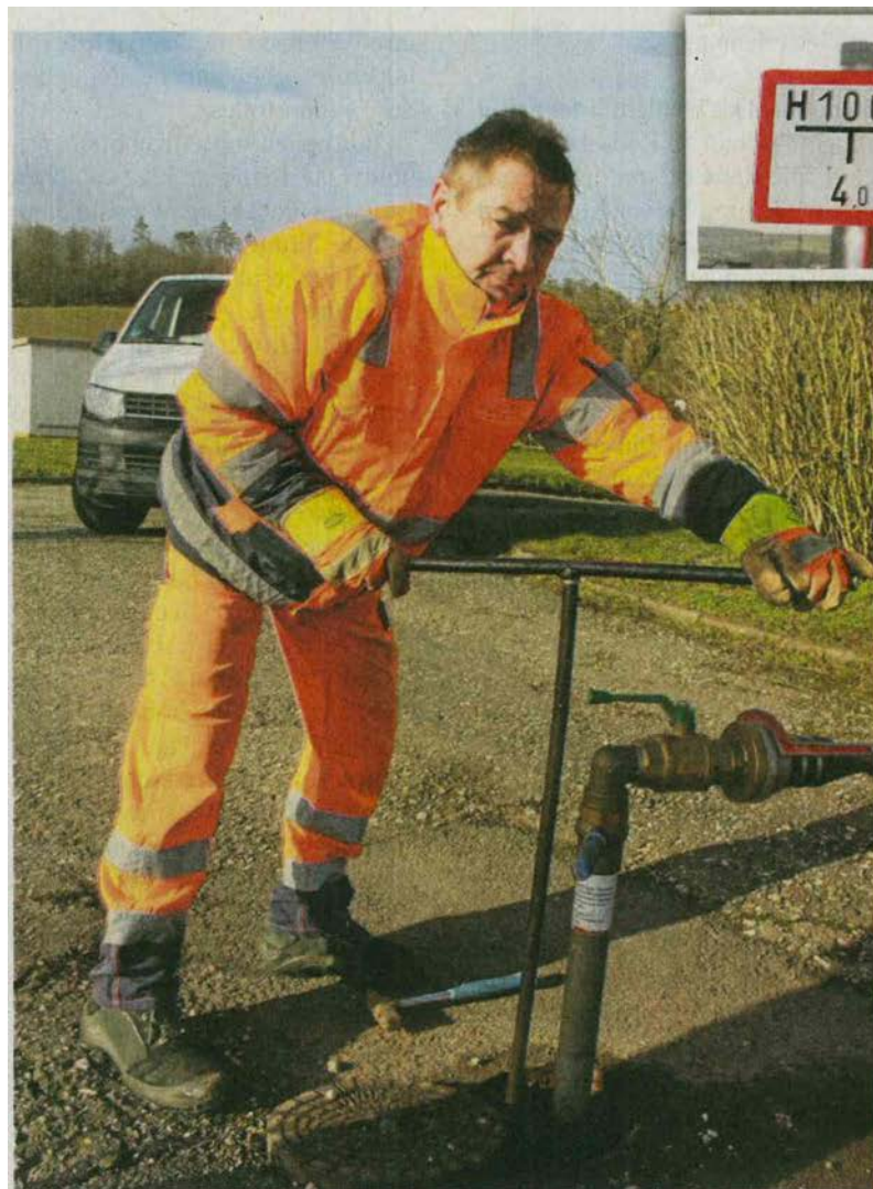
Mitarbeiter des Zweckverbandes Trinkwasserversorgung und Abwasserbeseitigung Eisenberg kontrollieren einen Unterflur-Hydranten am Ende der Waldstraße in Crossen auf seine Funktionstüchtigkeit. Im Außendienst sind Vorarbeiter Gunter Prüfer und die Instandhaltungsmechaniker Rohr/Netz Sylvio Zötzl und Marko Schmidl im Einsatz.
