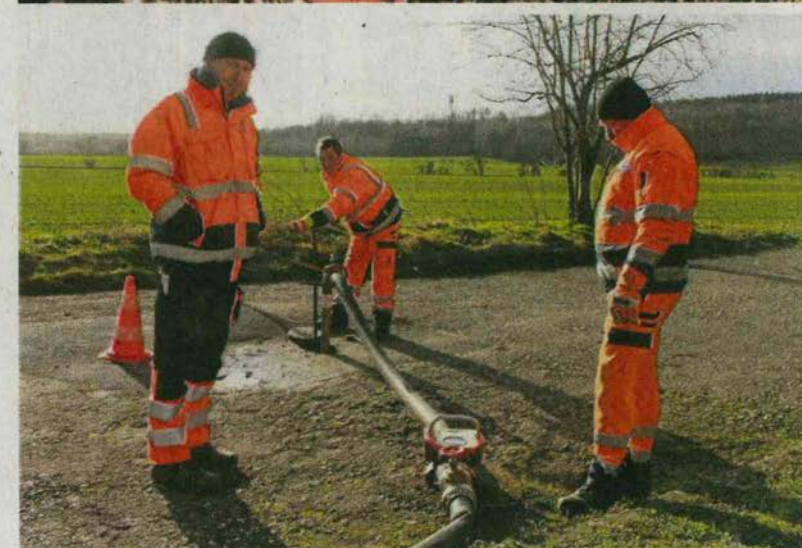
Mitarbeiter des Zweckverbandes Trinkwasserversorgung und Abwasserbeseitigung Eisenberg kontrollieren einen Unterflur-Hydranten am Ende der Waldstraße in Crossen auf seine Funktionstüchtigkeit. Im Außendienst sind Vorarbeiter Gunter Prüfer und die Instandhaltungsmechaniker Rohr/Netz Sylvio Zötzl und Marko Schmidl im Einsatz.
