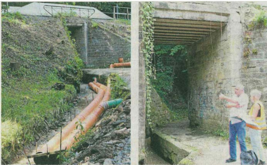
Der Malzbach wird während der Bauarbeiten verrohrt.
