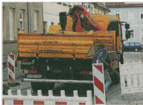
Verkehrsleiteneinrichtungen werden nach dem Ende der Bauarbeiten wieder abgebaut. FOTOS (2): ANGELIKA MUNTEANU
