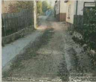
Im Friedensweg sind neue Leitungen und Leerrohre verlegt worden. Foto: Florian Girwert
