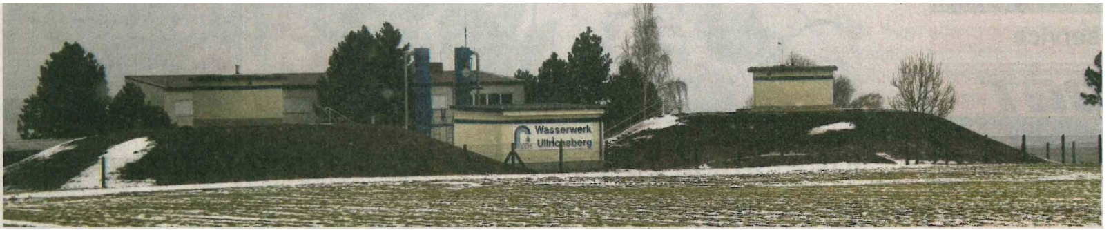
Wasserwerk Ullrichsberg bei Schkölen des Zweckverbandes Trinkwasserversorgung und Abwasserbeseitigung Eisenberg (ZWE). Über das Wasserwerk werden etwa 20 000 Verbraucher in Schkölen, Eisenberg und sogar in Jena und in Molau in Sachsen-Anhalt versorgt. Fotos: Angelika Munteanu
