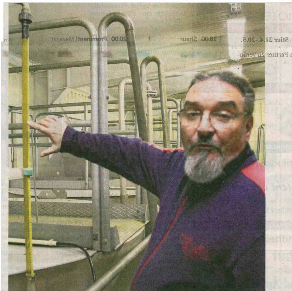
Wasserwerker Jörg Reichel erläutert die Filteranlage im Wasserwerk Ullrichsberg. mehr Bilder: www.otz.de
