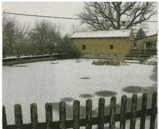
Der Löschteich in Lindau: Als solcher ist er nicht mehr qualifiziert, weil undicht. Foto: Susann Grunert
