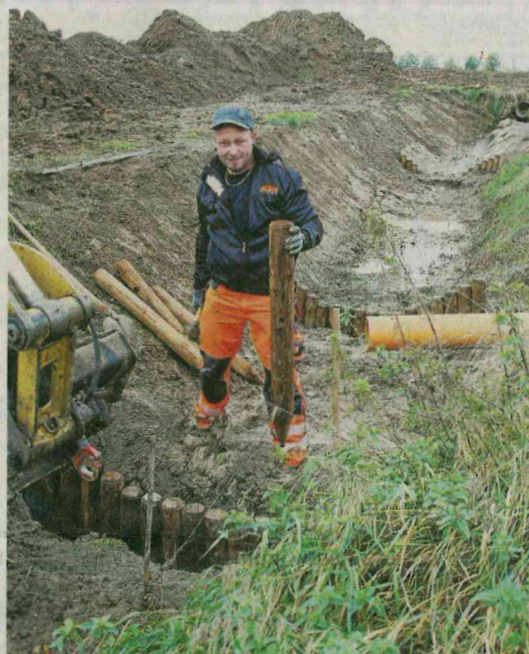
Christian Fulsche von der ITS Naumburg errichtet ein Auslaufbauwerk in dem alten Bachbett, in das bald das biologisch geklärte Thierschnecker Ab- und Regenwasser läuft.
