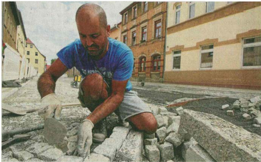
Altstadtsanierung in Eisenberg. Luis Veira legt auf der Baustelle in der Karl-Liebknecht-Straße das neue Pflaster gelegt. Foto: Angelika Munteanu
