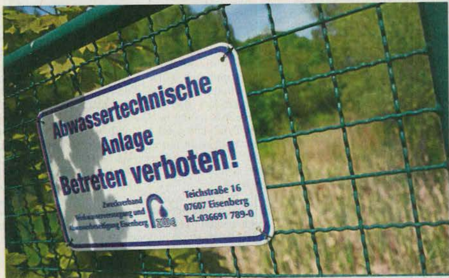
Die Regenrückhaltebecken in Eisenberg sorgen für Verstimmung. Die Verantwortlichen betonen, dass die Anlage in Ordnung ist. Foto: Martin Hauswald
