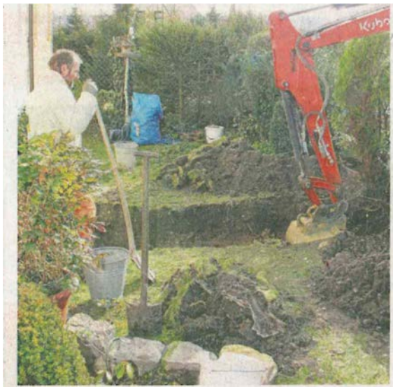
Bauarbeiten für Wasser und Abwasser an der Teufelshohle in Eisenberg. Foto: Angelika Munteanu
