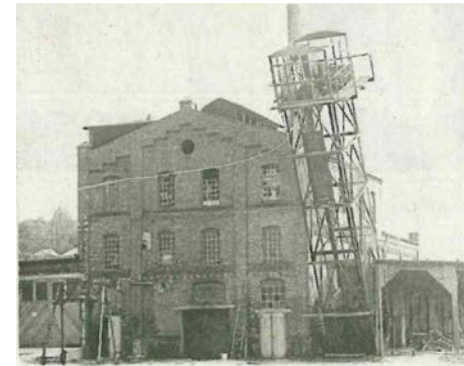
Abriss des alten Gaswerkes in Eisenberg im Oktober 1970. Quelle: Stadtarchiv Eisenberg
