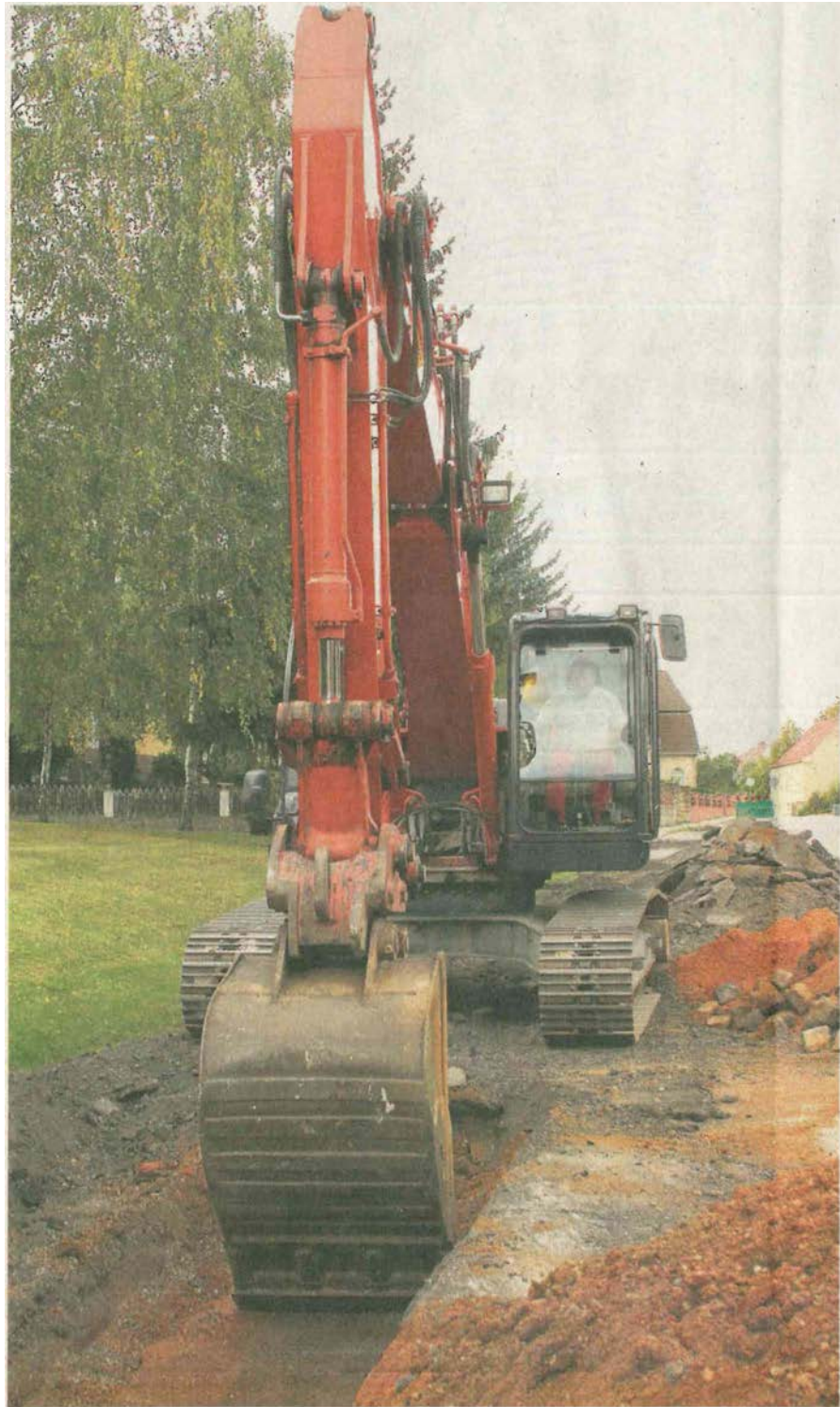
Mit dem grundhaften Ausbau von Straßen in Schkölen lässt der Zweckverband Trinkwasserversorgung und Abwasserbeseitigung Eisenberg auch neue Trinkwasserleitungen legen und die Grundstücke an die zentrale Abwasserentsorgung anschließen. Der alte Kanal wird künftig für Regenwasser genutzt. Foto: Angelika Munteanu
