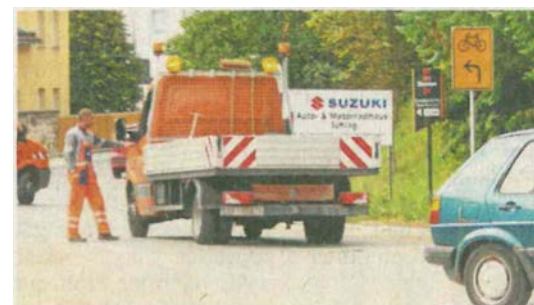
Unmittelbar nach der Freigabe werden die Sperren abgebaut. Mehr Bilder: eisenberg.otz.de
