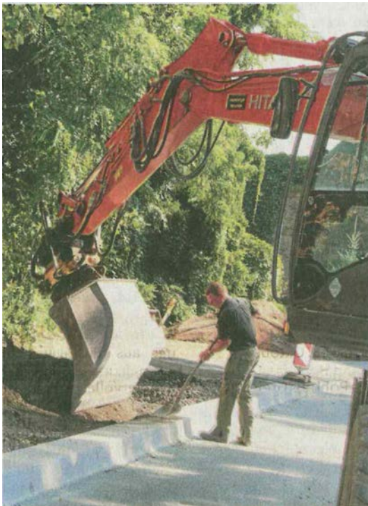
Gegenüber dem Gut in Hartmannsdorf wird die Haltebucht für Linienbusse gebaut, die auch ein Wartehäuschen erhalten wird. mehr Bilder: www.otz.de
