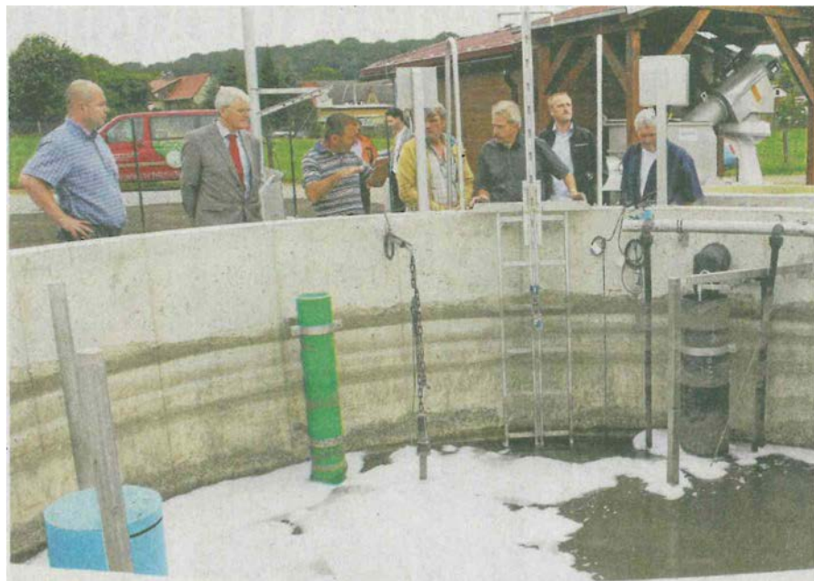
Die Kläranlage in Mertendorf wird vom Zweckverband Trinkwasserversorgung und Abwasserbeseitigung Eisenberg in Betrieb genommen. Die Anlage gilt als Pilotprojekt für die zentrale Abwasserbeseitigung auf dem Dorf. Foto: Angelika Munteanu
