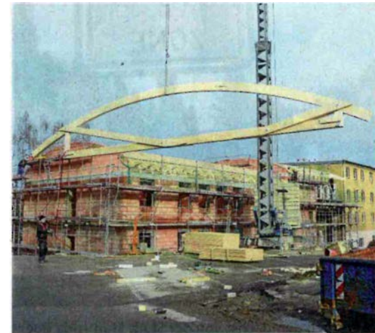
Die vorgefertigten Binder aus Brettschichtholz werden auf das Gebäude gehoben. Foto: Andreas Kratsch
