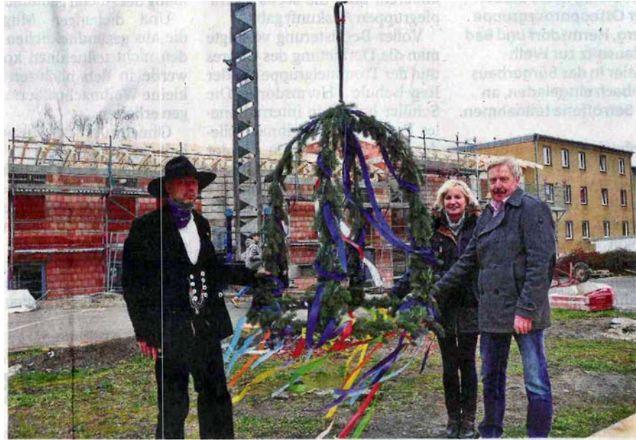
Von links: Zimmerermeister Jörg Pfeiffer, ZWE-Geschäftsführerin Ute Böhm und Verbandsvorsitzender Matthias Darnstädt an der Richtkrone beim Richtfest am gestrigen Nachmittag in Eisenberg. Foto: Andreas Schott
