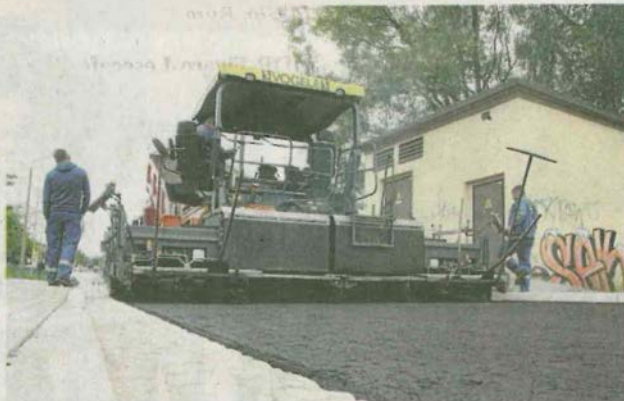
In der Saasaer Straße in Eisenberg wird eine neue Asphalttragschicht eingebaut. Foto: Julia Schäfer
