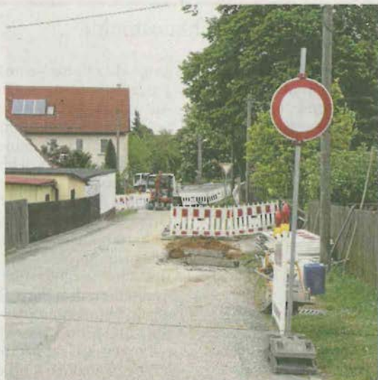
Der ZWE erneuert die Trinkwasserleitungen und verlegt gleichzeitig Abwasserrohre im Etzdorfer Mittelweg. Foto: Julia Schäfer
