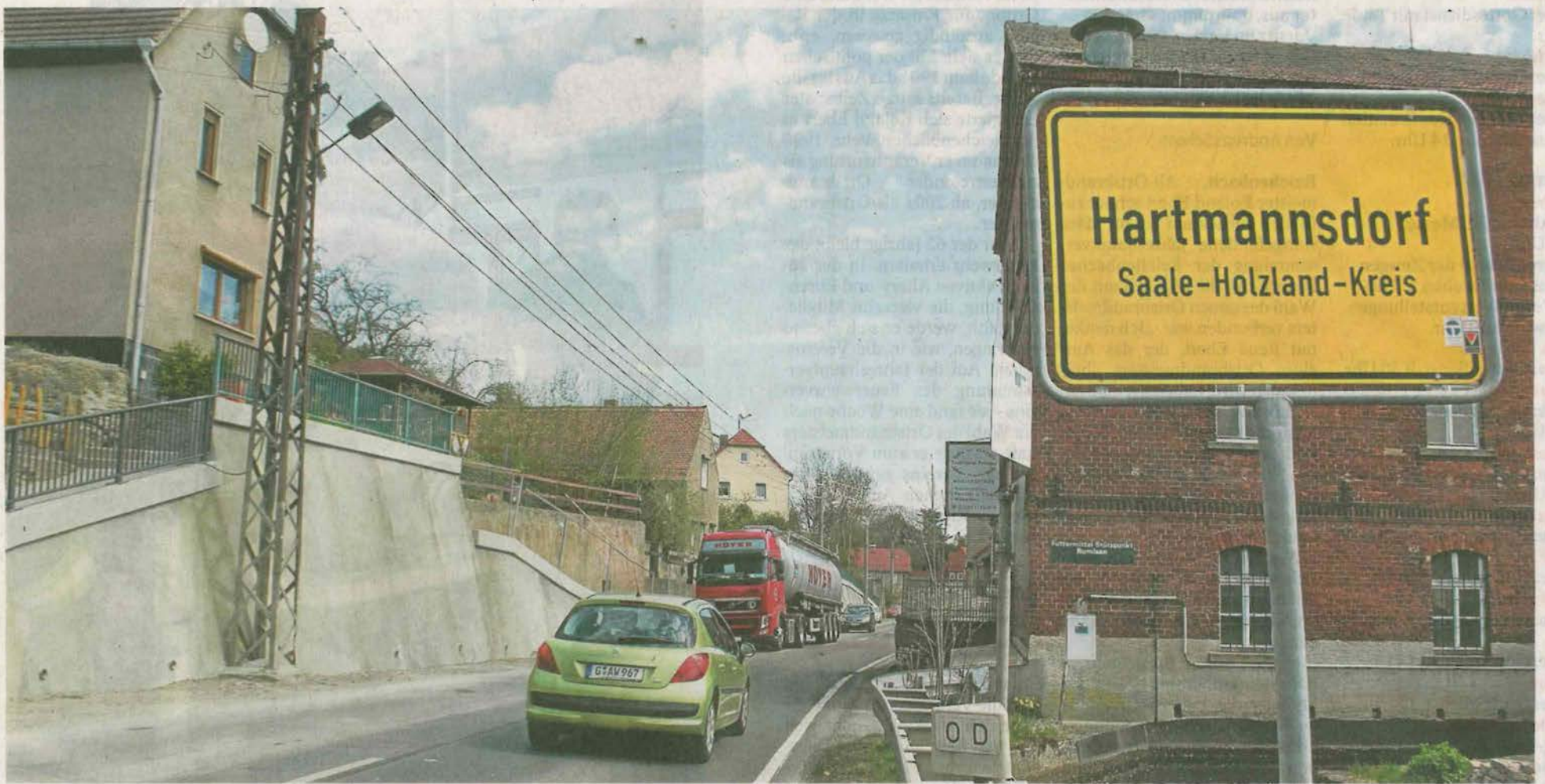
Im Zuge der „rückständigen Erhaltung“ wird die Eisenberger Straße in Hartmannsdorf ab 11. Mai zur Baustelle. Bis zur Einmündung am Glockenturm wird 2015 gebaut. Die Straße ist hier seit Jahresbeginn nicht mehr Bundes-, sondern nur noch Landesstraße L 3007. Foto: Angelika Schimmel
