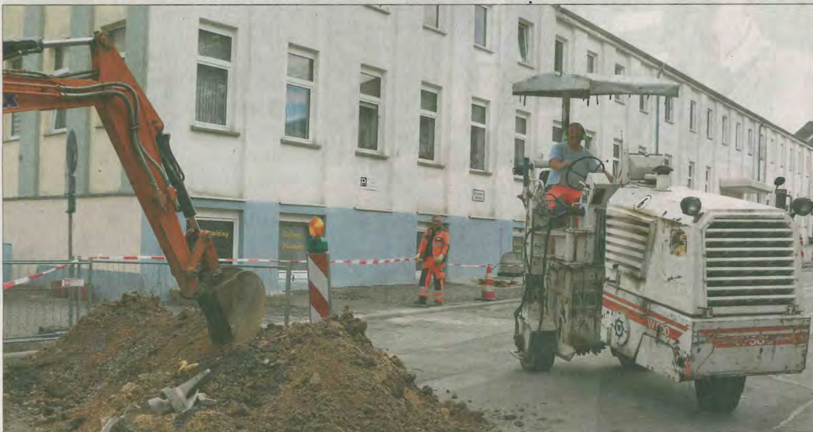
Ronald Kämmer-Licht, auf dem Baufahrzeug sitzend, und Rainer Frauenfelder arbeiteten gestern in der Goethestraße, die eine neue Asphaltdecke bekommt. Mehr Fotos unter: www.otz.de/eisenberg Foto: Ute Flamich
