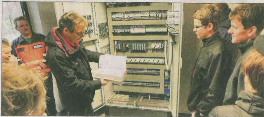
Matthias Fiedler (3. von links) von der bauausführenden Firma ZWT Schleiz, informierte die Bürger über die neue Kläranlage in Schkölen. Foto: Dieter Urban
