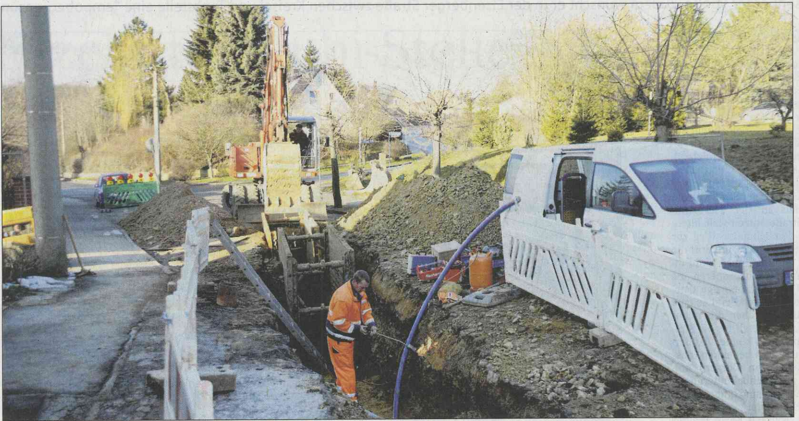
Mitarbeiter der Firma Hoch- und Tiefbau Schmidt aus Osterfeld sind derzeit dabei, den Abwasserkanal zum Bahnhofsviertel zu ziehen, wo Hauseigentümer bereits ihre Anschlüsse vorbereitet haben. Parallel werden die Versorgungsmedien erneuert. Foto: Oliver Will
