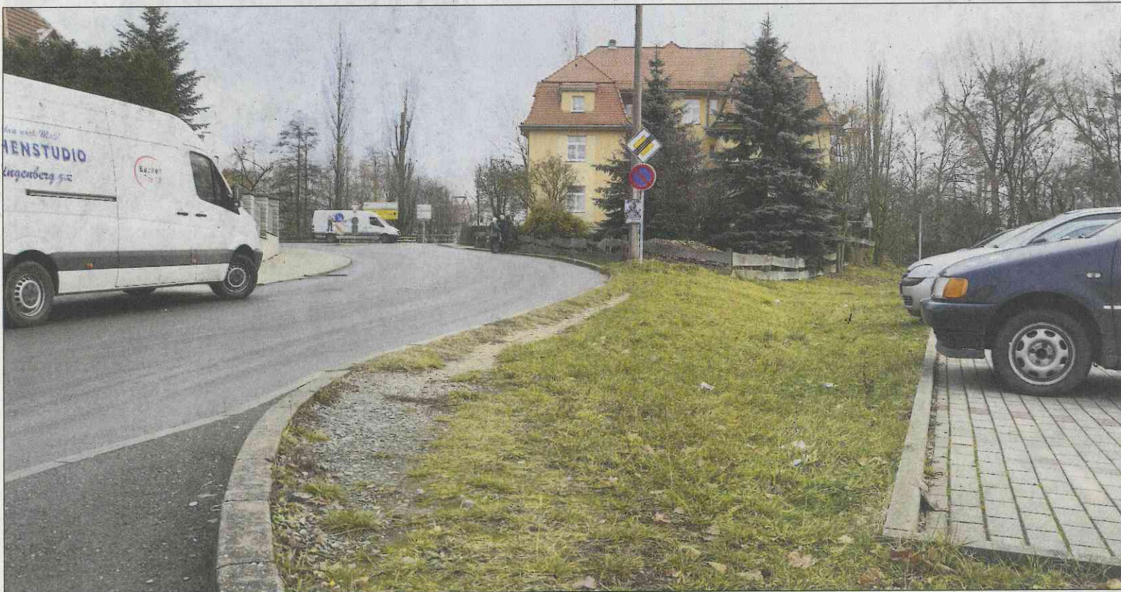
Im Zuge des Ausbaus der Saasaer Straße werden auch neue Gehwege angelegt. Der Seniorenbeirat der Stadt hatte das Fehlen von Bürgersteigen, insbesondere im Bereich des Aldi-Marktes, stets kritisiert. Foto: Archiv/Oliver Will
