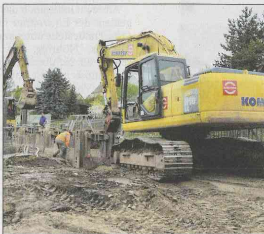
Seit dem Frühjahr laufen die Arbeiten für den Anschluss Schkölens an die neue Kläranlage, die inzwischen fertig ist. Foto: Archiv/Oliver Will
